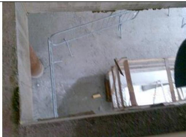
Sul Primo piano o in caso le forometrie non siano perfettamente allineate è necessario ampliare le protezioni sul piano più basso in modo che la zona non sia transitabile da persone che potrebbero essere investite dalla caduta di materiale dall'alto.
