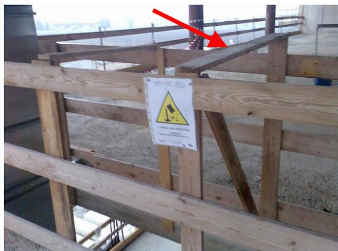
Evitare la messa in opera di traverse che impediscono il passaggio dei canali
