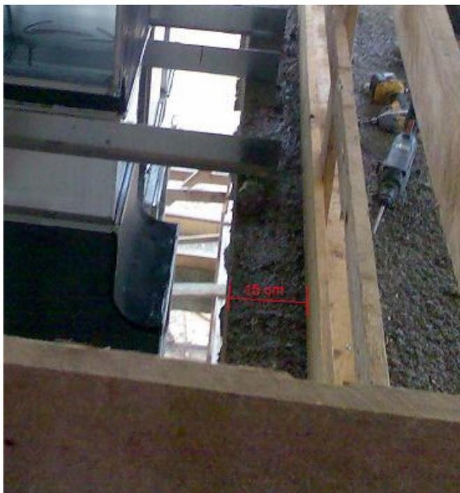
La distanza tra filo foro e filo interno del parapetto dovrà essere di almeno 15 cm al fine di consentire l'appoggio delle traverse dei sostegni dei canali
