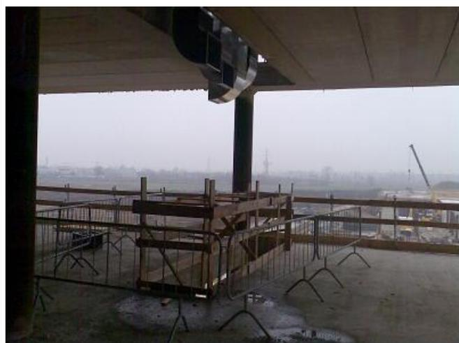
L'ampliamento della protezione deve avvenire con l'impiego di transenne metalliche posizionate in modo da impedire l'accesso ai non addetti ai lavori.
